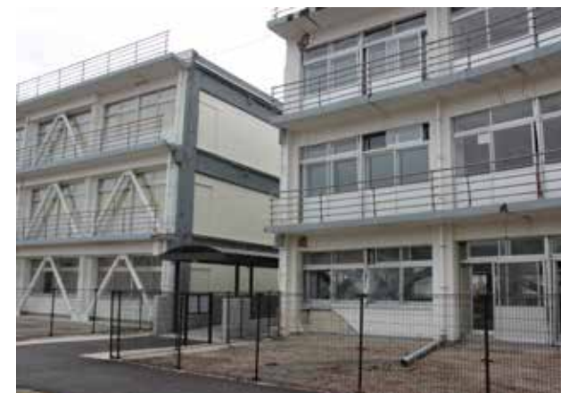
▲耐震補強の有無による被害の差が観察できる一号館
