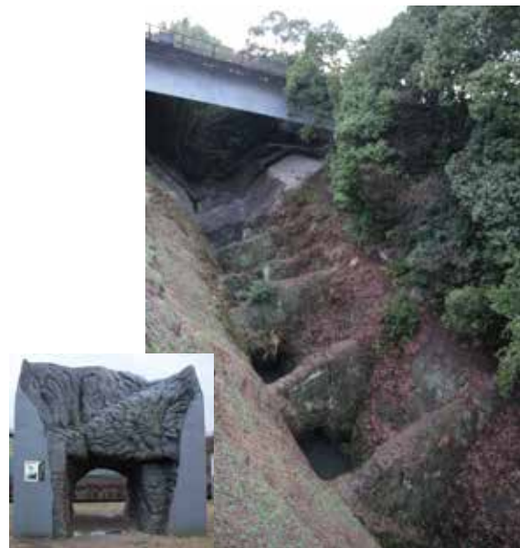
▲掘削時に一部を壁のように残し、その下辺をくりぬいてトンネル状にした「鼻ぐり」は、工事を簡略化し、水流により川底に土砂がたまらないようにする仕組み
