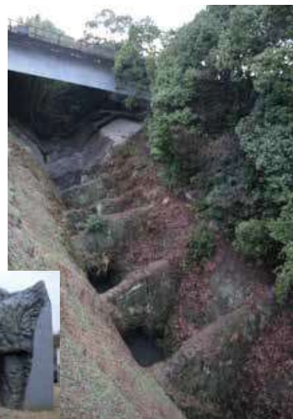
▲掘削時に一部を壁のように残し、その下辺をくりぬいてトンネル状にした「鼻ぐり」は、工事を簡略化し、水流により川底に土砂がたまらないようにする仕組み
