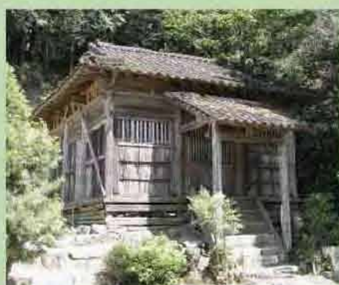
国指定重要文化財 建造物 はっしょうじ 八勝寺阿弥陀堂 18
