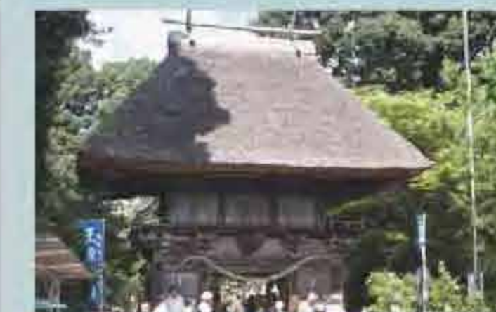
県指定重要文化財 建造物 おうぐ 王宮神社楼門 11
