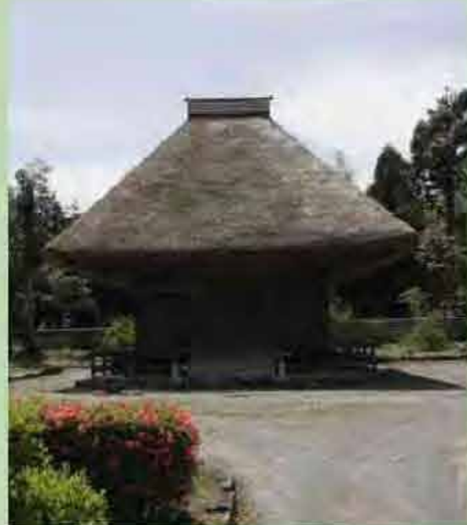
国指定重要文化財 建造物 みょうどうじ 明導寺阿弥陀堂 17
